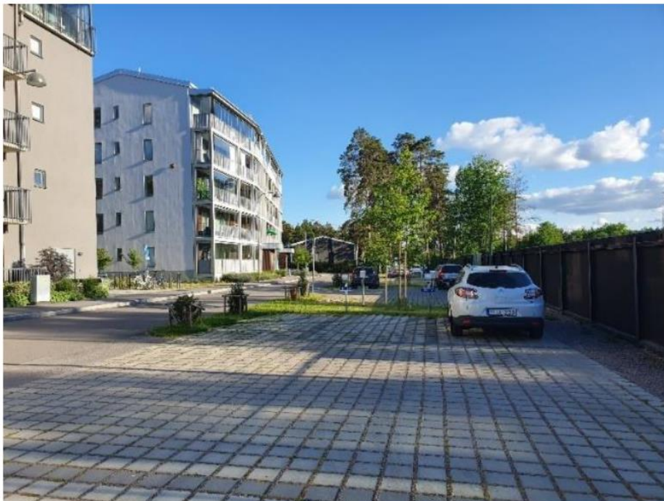
Parkeringsyta bestående av marksten med genomsläppliga fogar vid bostadsområde i Linköping (foto Tyréns). Dagvattenutredning, Tyréns, 2021.
